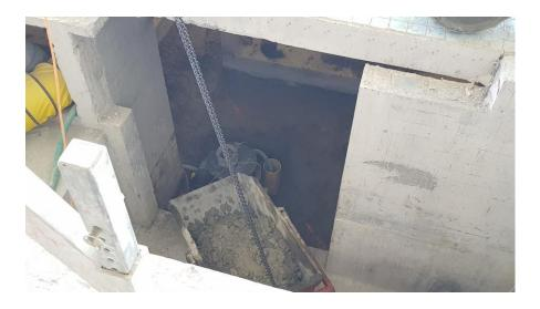
Im Duschentrackt mussten sämtliche Bodenabläufe freigelegt werden. Massiver Beton erschwert auch hier die Arbeiten.
